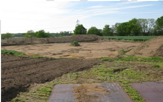
Abbildung 4: Abtrag des Oberbodens
