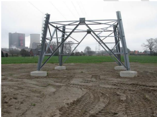
Abbildung 13: Plattenfundament nach der Verfüllung der Baugrube
