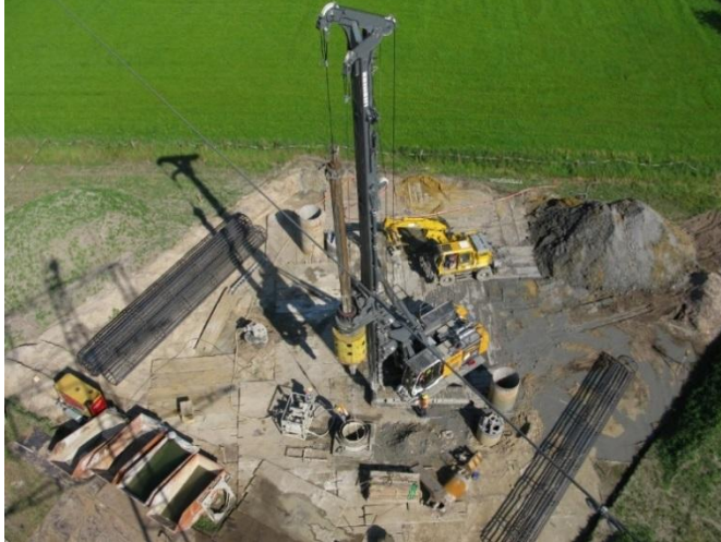
Abbildung 5: Erstellung der Bohrpfähle
