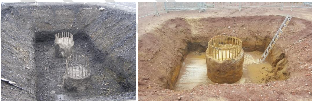
Abbildung 6: Freilegen der Bohrpfähle
