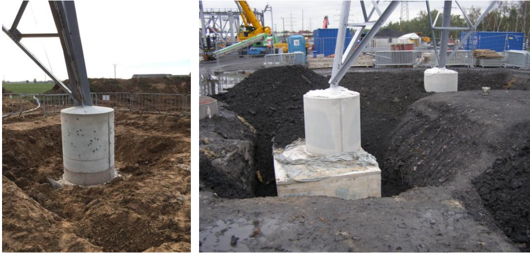
Abbildung 10: Anbindung der Eckpfähle nach dem Betonieren
