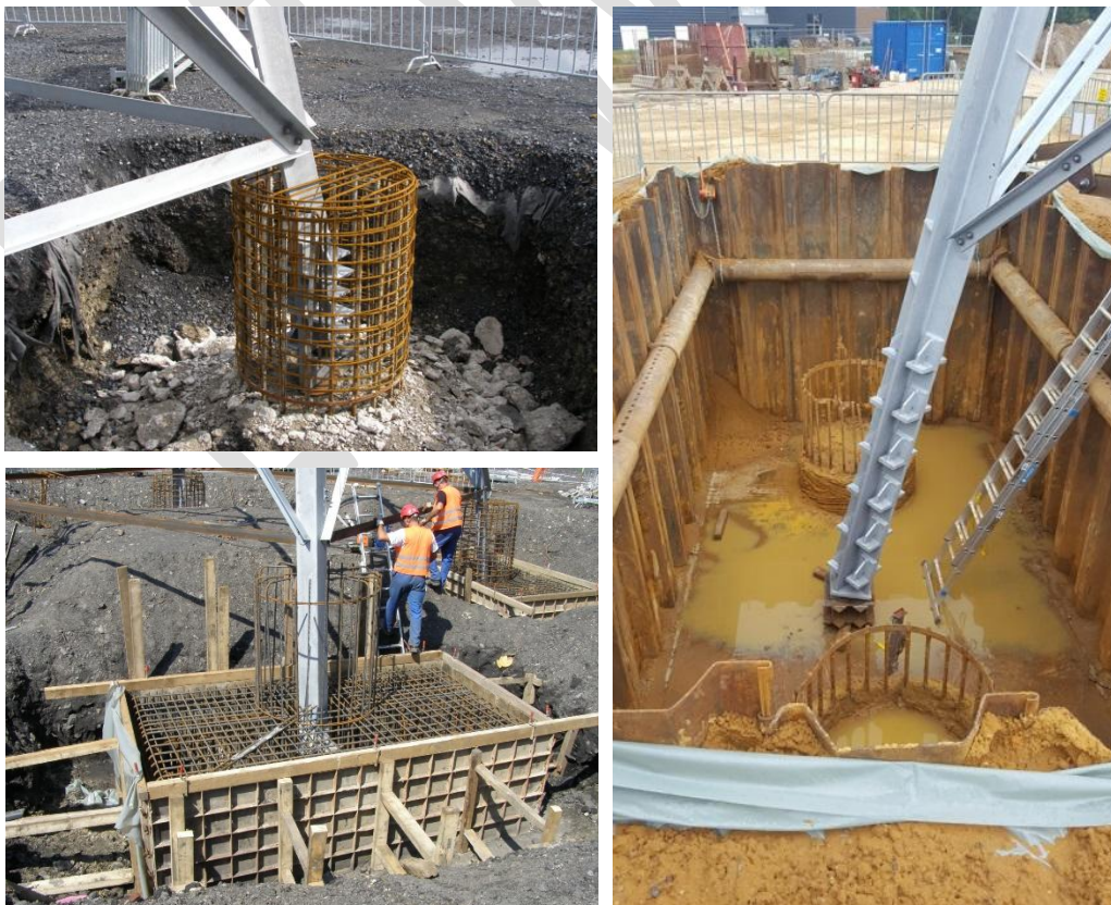
Abbildung 9: Anbindung der Eckpfähle vor dem Betonieren
