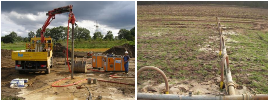
Abbildung 7: Einrichtung der Wasserhaltung mittels Spüllanzen
