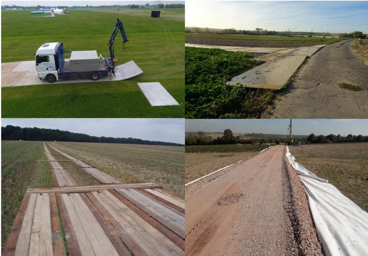
Abbildung 6: temporärer Wegebau Aluminium Fahrplatten (oben links), Stahlplatten (oben rechts), Fahrbohlen (unten links) und Schotter auf Geotextil (unten rechts)
