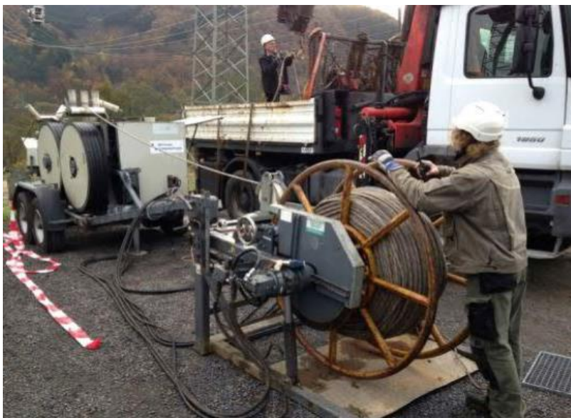
Abbildung 9: Seilbremse und -winde
