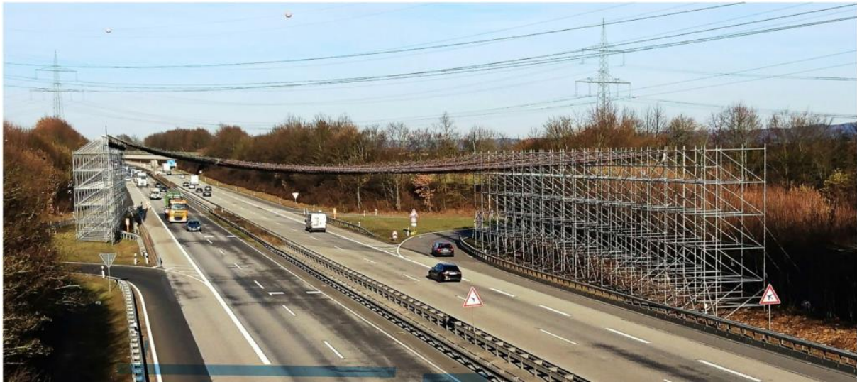
Abbildung 10: Beispiel Schutzgerüst, hier: BAB 61 Rastplatz Moseltal im Zuge der Arbeiten an der parallel verlaufenden DB-Leitung Nr. 444
