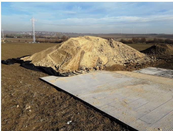
Abbildung 7: Beispiel für eine Unterbodenmiete auf Geotextil
