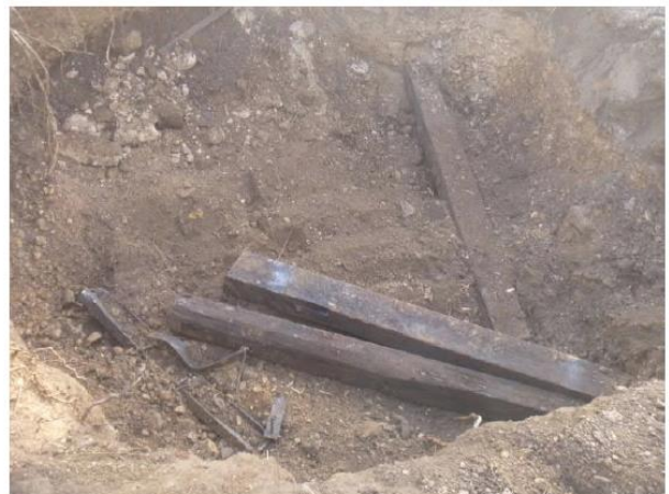
Abb. 3: Schwellen nach der Trennung von Stahl [3]
