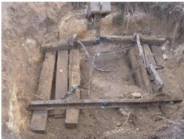
Abb. 2: Schwellen und Stahl werden voneinander in Baugrube getrennt [3]
