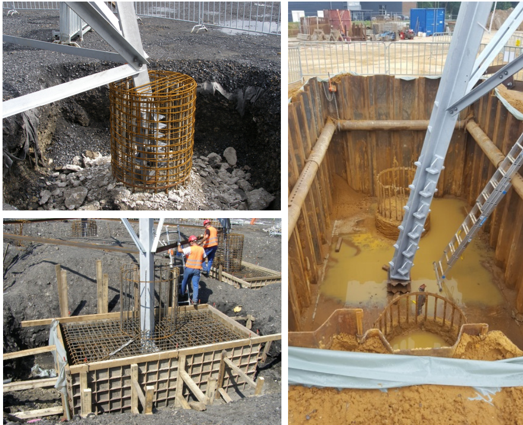
Abbildung 9: Anbindung der Eckpfähle vor dem Betonieren
