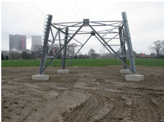
Abbildung 13: Plattenfundament nach der Verfüllung der Baugrube
