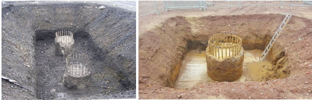
Abbildung 6: Freilegen der Bohrpfähle
