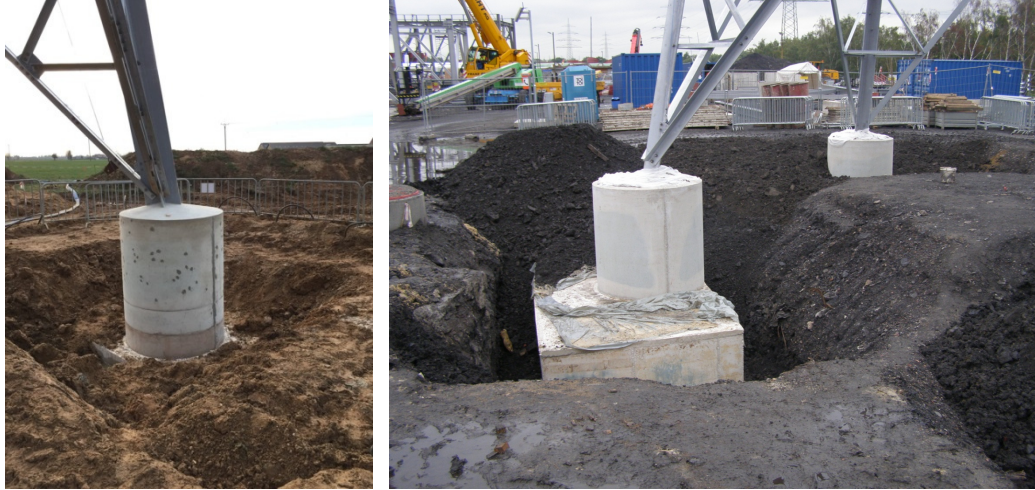
Abbildung 10: Anbindung der Eckpfähle nach dem Betonieren
