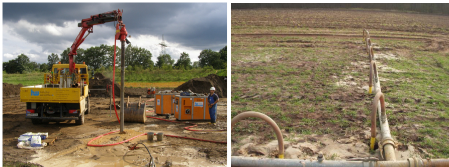
Abbildung 7: Einrichtung der Wasserhaltung mittels Spüllanzen
