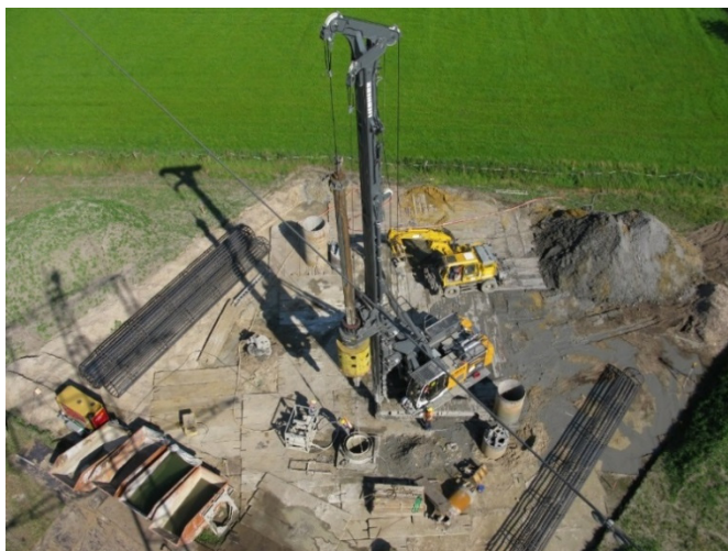
Abbildung 5: Erstellung der Bohrpfähle
