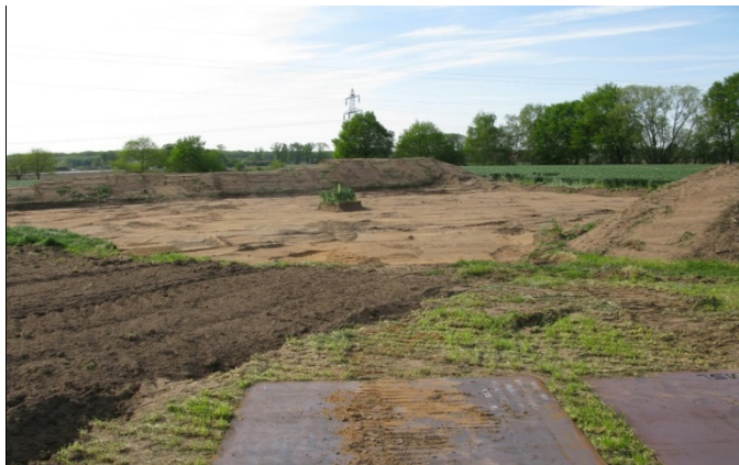
Abbildung 4: Abtrag des Oberbodens
